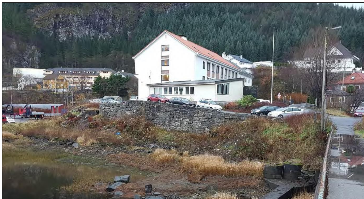
Figur 5-10: Kommunehuset og del av gjenværende fyllingsmur, Foto Byantikvaren 2018.
