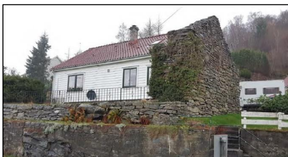
Figur 5-12: Selvikveien 6, nr. 4 på Figur 5-11. Våningshuset har en svært markant tørrmurt gavlvegg mot øst. Foto Byantikvaren 2018
